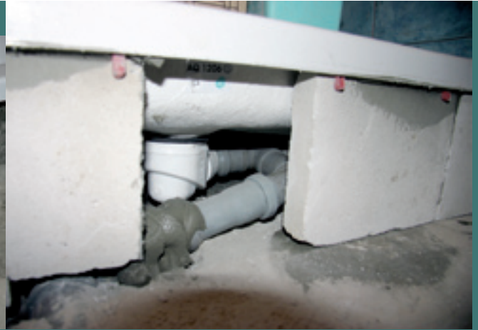
Postavljanje tuškabine (koju se tako dugo čekalo...)
