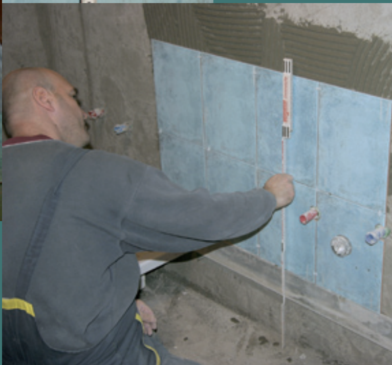
Na red dolazi postavljanje keramičkih pločica!
